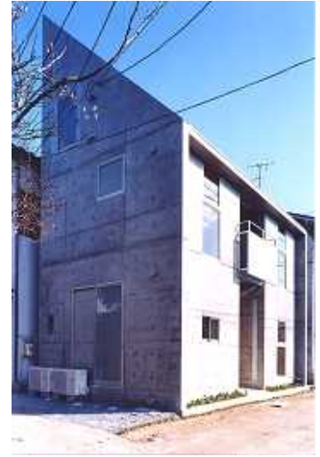
北立面から（土の道）
